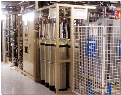
東北大学のリキセル®コンタクター（給気・脱気膜）を用いたウェーハ処理システム
