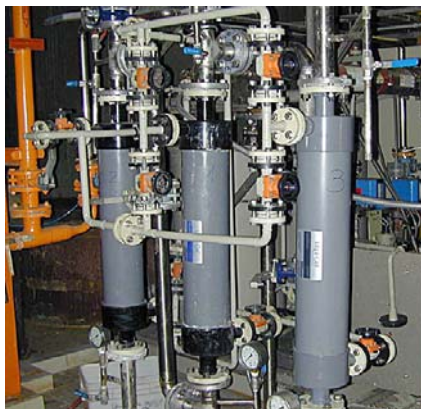
ヨーロッパの施設におけるアンモニア廃水を効果的に処理するリキセル分離膜コンタクター(脱気膜)
