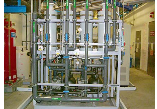
第一ステージの二酸化炭素と酸素除去のリキセル分離膜装置
