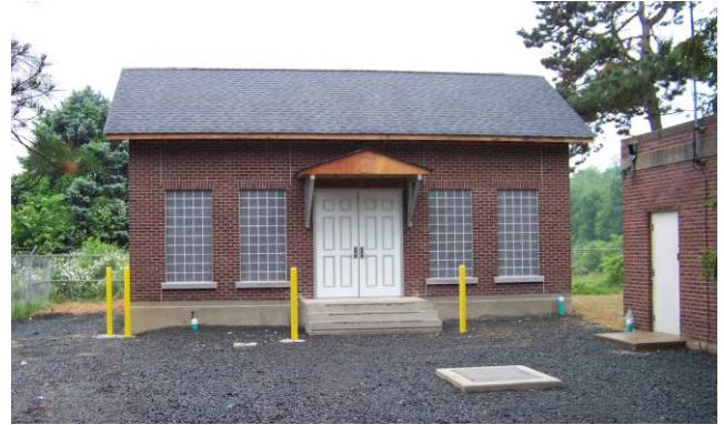
リキセル ® 脱気膜装置がある建物が建設された。居住地域に建てられるため概観にも配慮する必要がある。
